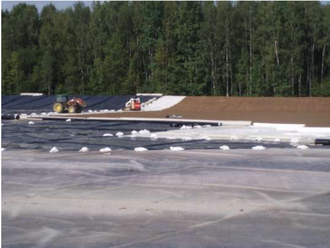
11. attēls. Atkritumu krātuves pamatnes izolējošā klājuma būvniecība bīstamo atkritumu poligonā Dobeles rajona Zebrenes pagastā.
