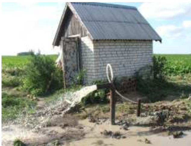
2.6. attēls. Divu (sekli gruntsūdeņi un artēziskie ūdeņi) urbumu grupa pie Bērzes drenu lauka monitoringa stacijas.
