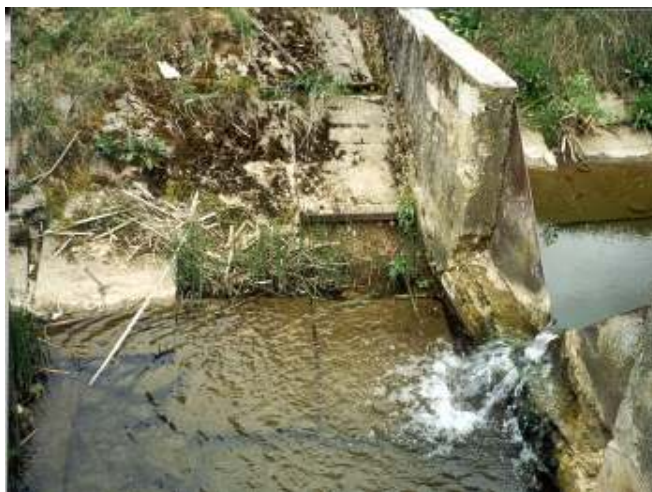
2.4. attēls. Mērbūve Bērzes monitoringa objektā pirms rekonstrukcijas 2005. g. rudenī.
