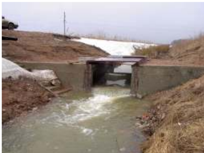
2.5. attēls. Bērzes stacijas novadgrāvja baseina mērbūve pēc rekonstrukcijas.
