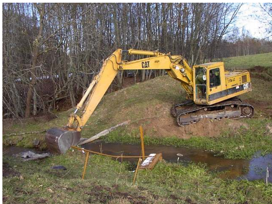
2.3. attēls. Mērbūves augšbjefa iztīrīšana no sanesām.
